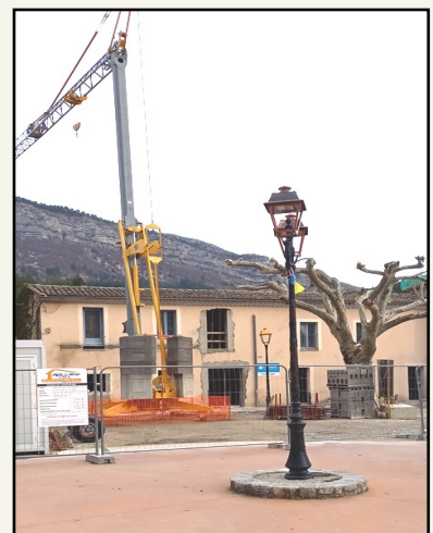
Photo travaux en cours
