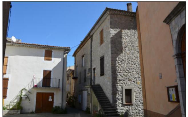
Maisons du centre avec leurs typiques escaliers par l'extérieur (adaptation de l'architecture aux inondations régulières).
