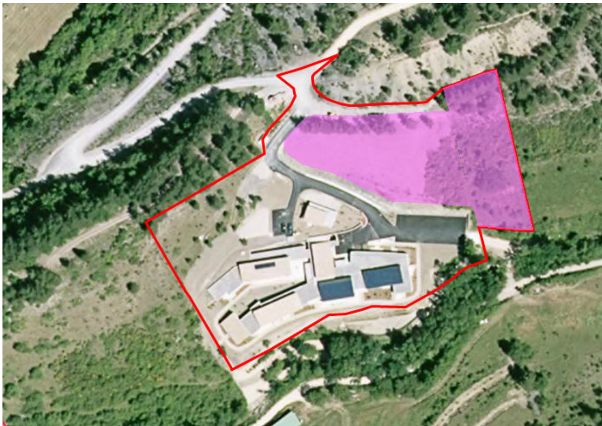
Localisation de la zone constructible de la MARPA. En rose est indiquée la parcelle visée par un projet d'urbanisation dans le cadre de la carte communale. Source : IGN BD ORTHO, 2013
