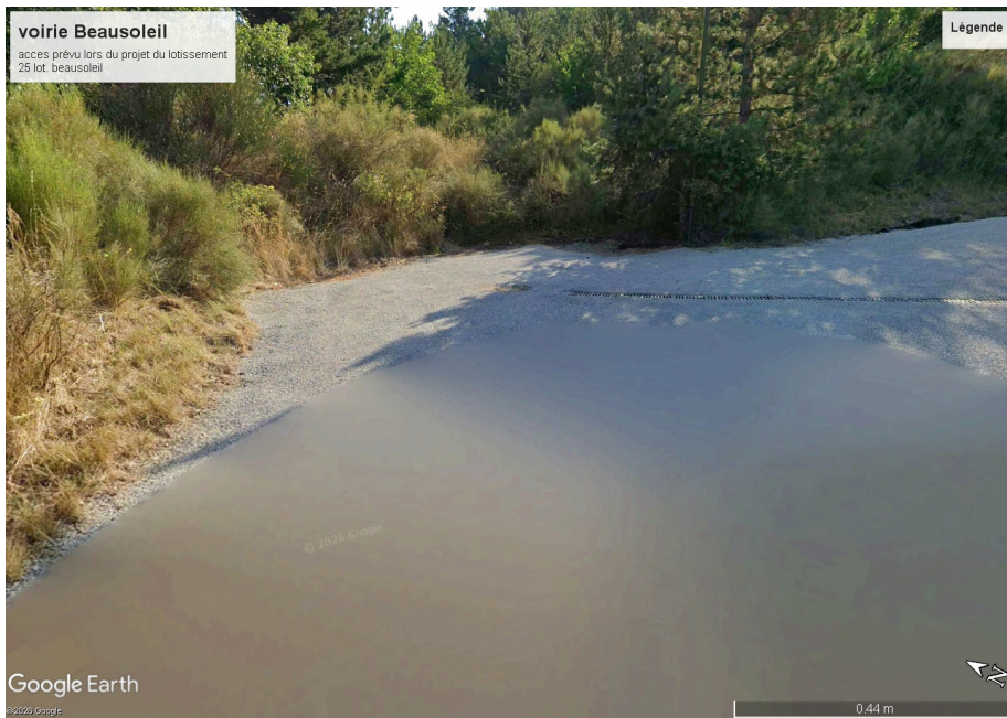
Photo de la prévision de voirie, il y a un regard des eaux usées et un caniveau des eaux pluviales.
